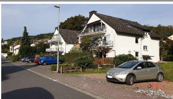
Foto 6: Bebauung im Langgraben 2-geschossig mit Satteldach
