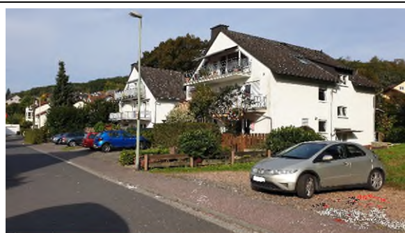
Foto 2: Bebauung im Langgraben 2-geschossig mit Satteldach
