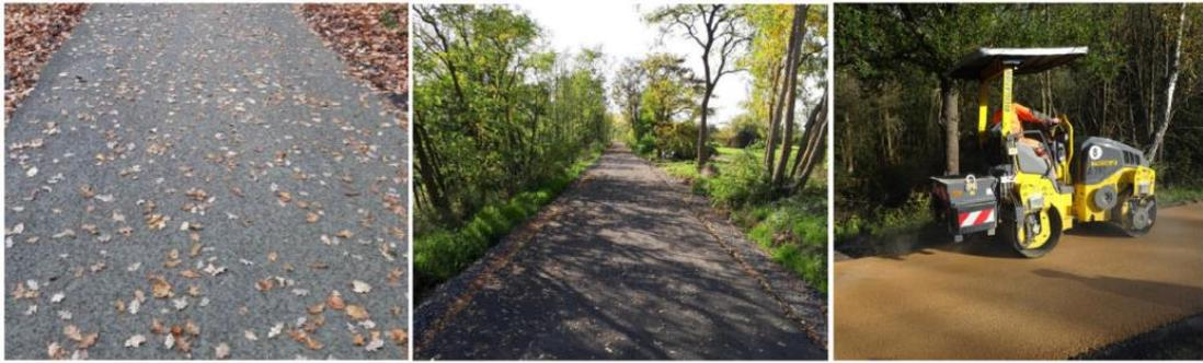
**Abbildung 3: Asphaltähnliche Deckschichten aus Gemisch von Basaltstein und Spezialsanden / heller Split-Mastix-Asphalt**
