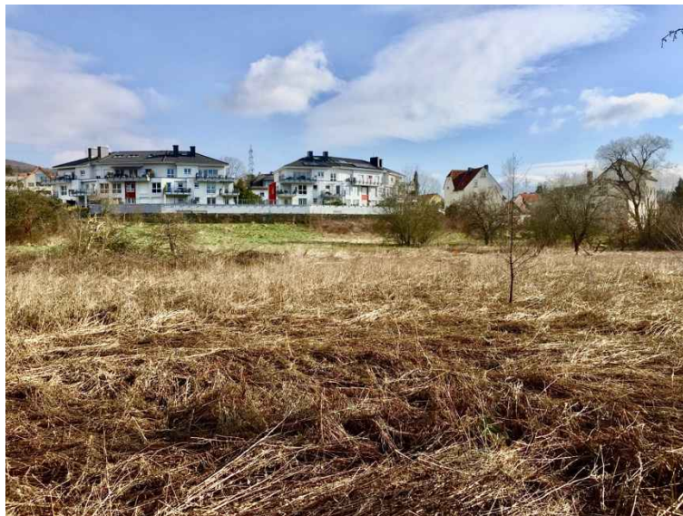
Nachbarbebauung Idsteiner Straße 31 – 33a vom Tal aus gesehen – Die Sockelzone mit den Tiefgaragen-Stellplätzen tritt unangemessen deutlich in Erscheinung
