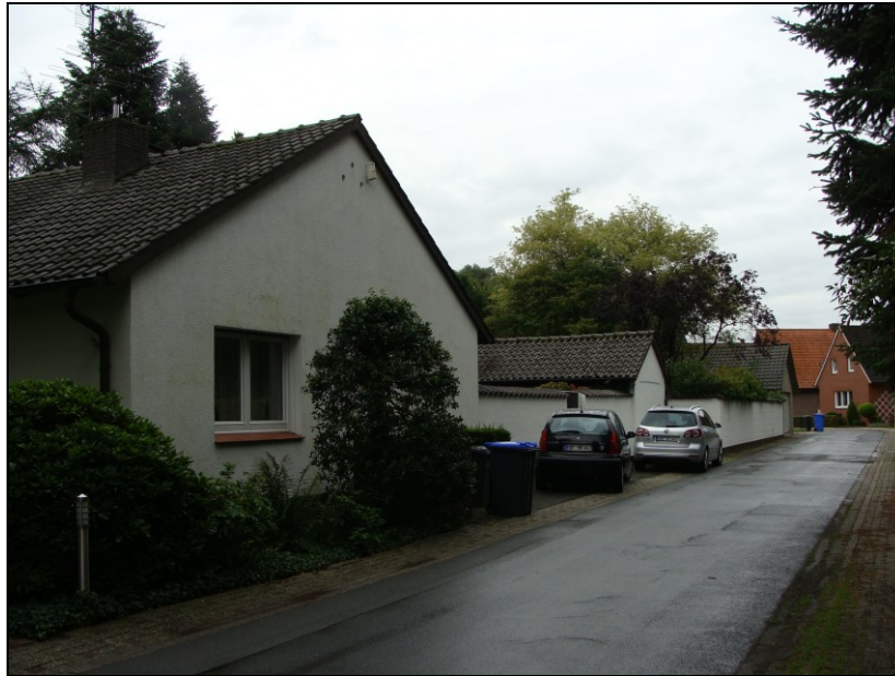
Abbildung 3: Straße Eichengrund - linke Straßenseite (von der Schorlemer Straße aus gesehen)
