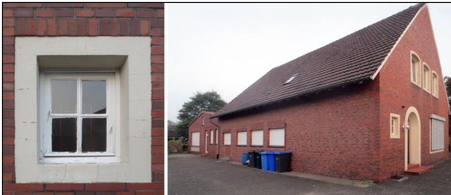
Abbildung 4: Vorhandenes Kindergartengebäude (Ansicht Nord-Ost)
