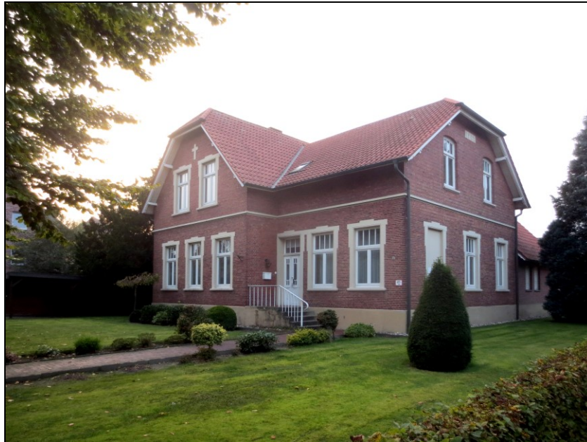
Abbildung 7: Ehemaliges Vikariegebäude (Ansicht Hörstingstraße)
