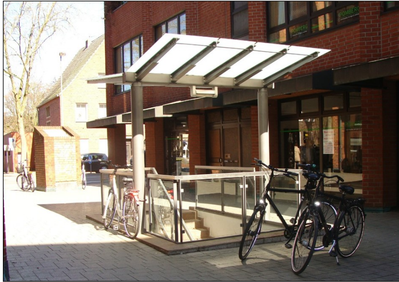
Abbildung 3: Treppenabgang Tiefgarage Königstraße
