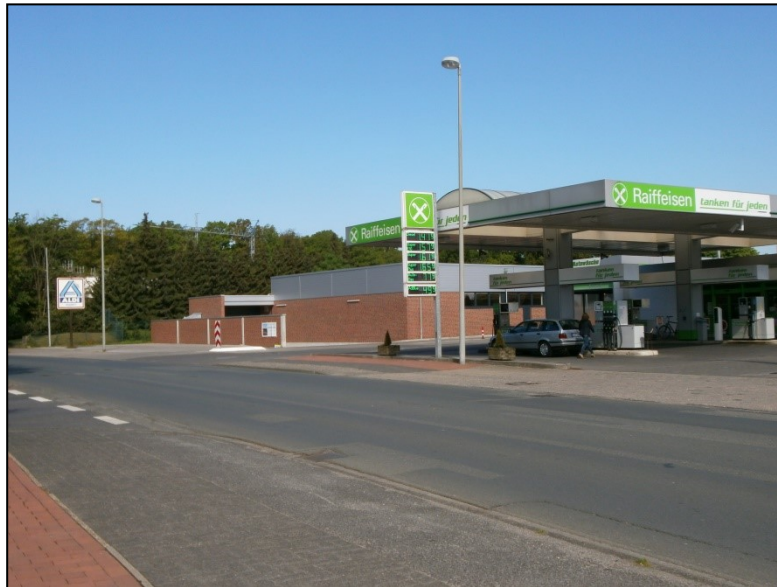
Abbildung 3: Straßenansicht Aldi-Markt, Fuistingstraße 66 (mit vorgelagerter Warenanlieferung), Blickrichtung Kreisverkehr am Stadtpark
