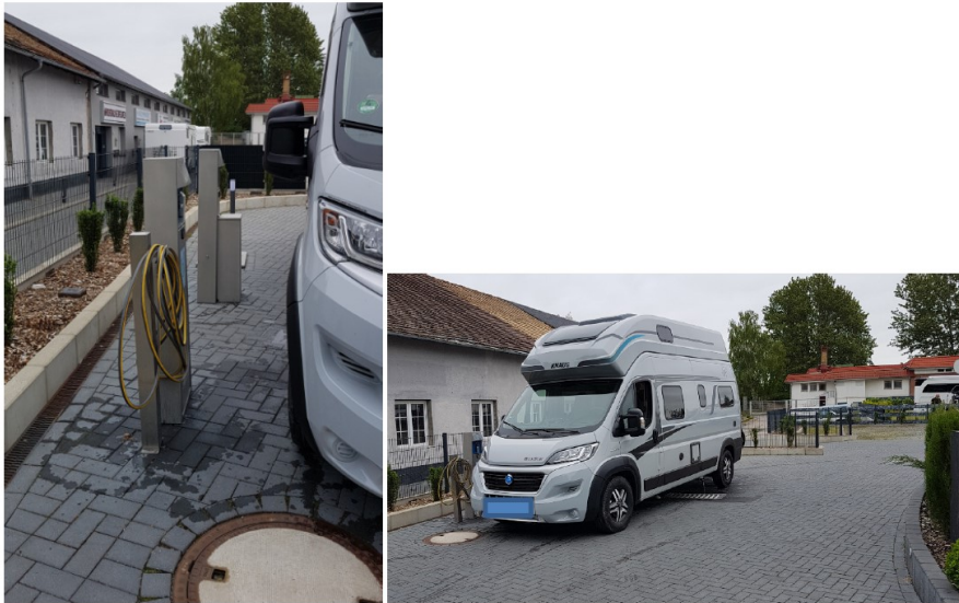
Abbildung 2: Beispiel einer modernen Ver-/Entsorgungsstation (©Stralsund)
