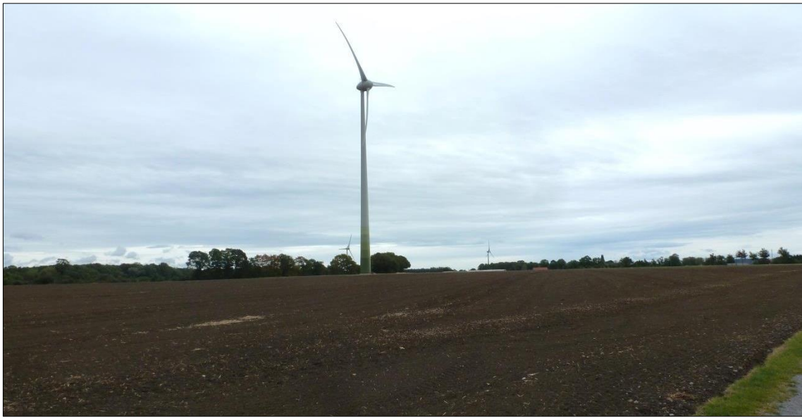
Abb. 13 Bestehende WEA in Bereich der Teilfläche „6a“
