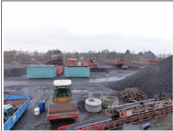
Bild B.1: Schotteraufbereitungsanlage
