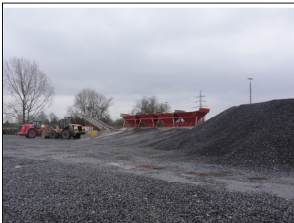
Bild B.3: Dosieranlage und Radlader
