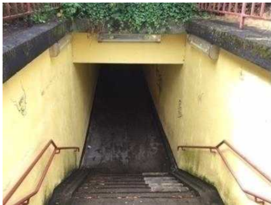
Unterführung K+K Markt in Neubeckum
