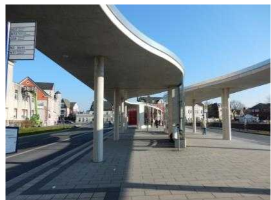
Busbahnhof in Beckum
