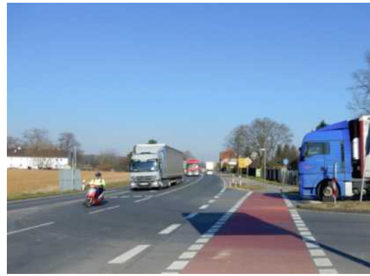
Knotenpunkt B 58/Vorhelmer Straße
