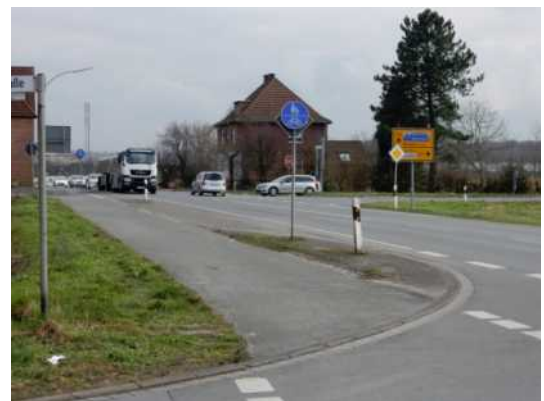
Ortsdurchfahrt Vorhelmer Straße
