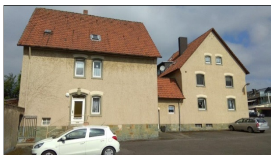
Wohngebäude Vorhelmer Straße 33a+33b
