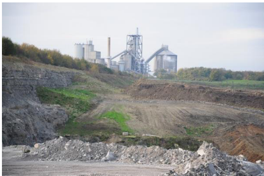
Abbildung 5 Südliche Böschung von Osten
