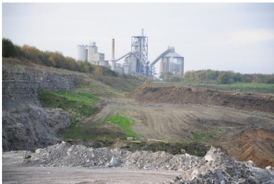
Abbildung 5 Südliche Böschung von Osten
