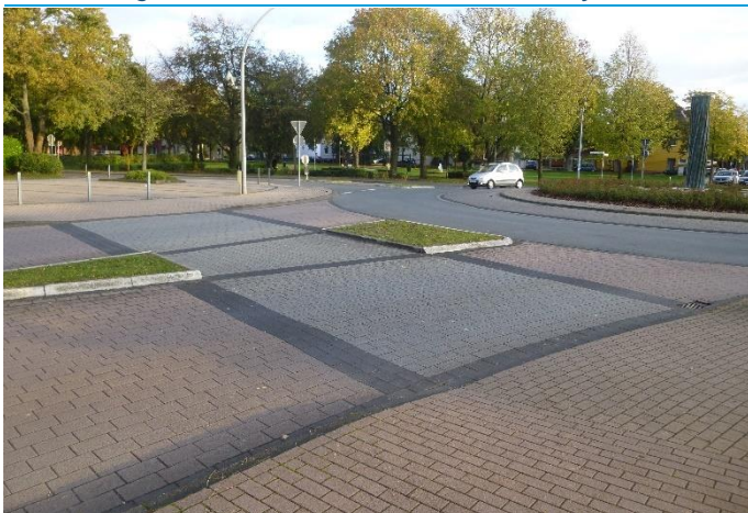
Abb. 5: Abgesenkter Bordstein ohne taktiles System in Neubeckum
