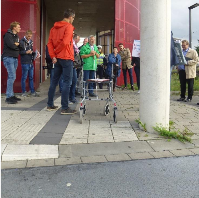
Abb. 7: Säule verringert die Breite des abgesenkten Bordes
