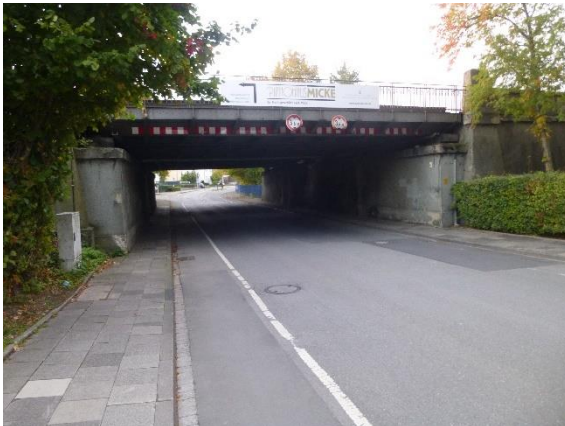
Abb. 22: Unterführung Ennigerloher Straße
