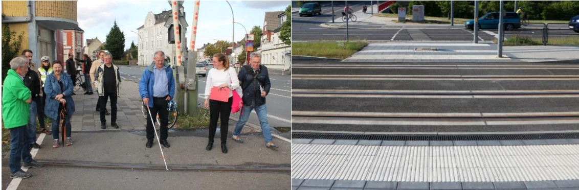
Abb. 9: ungesicherte Gleise in Beckum; Gleise in Chemnitz mit taktilen Elementen
