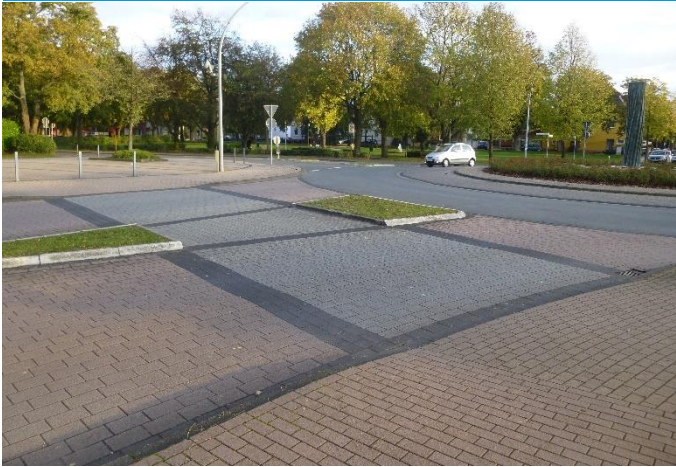
Abb. 5: Abgesenkter Bordstein ohne taktiles System in Neubeckum
