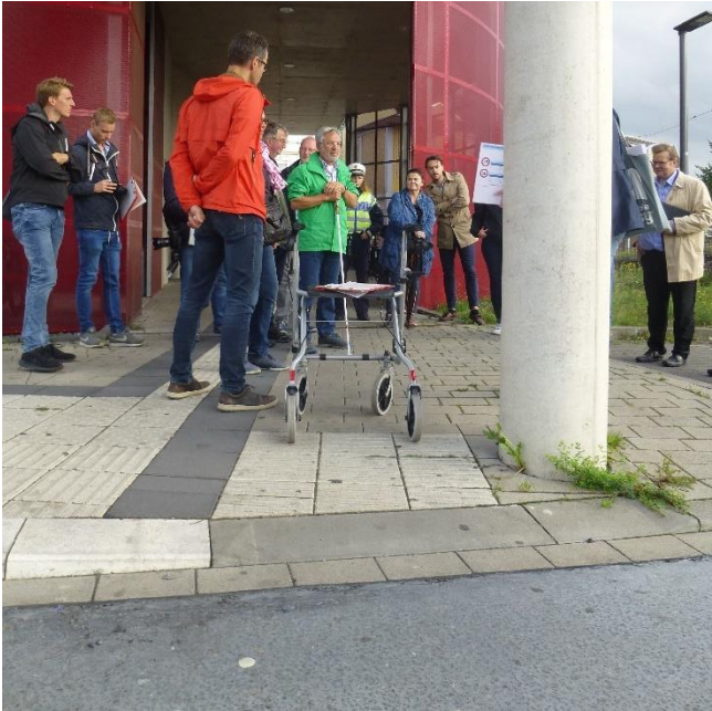
Abb. 7: Säule verringert die Breite des abgesenkten Bordes
