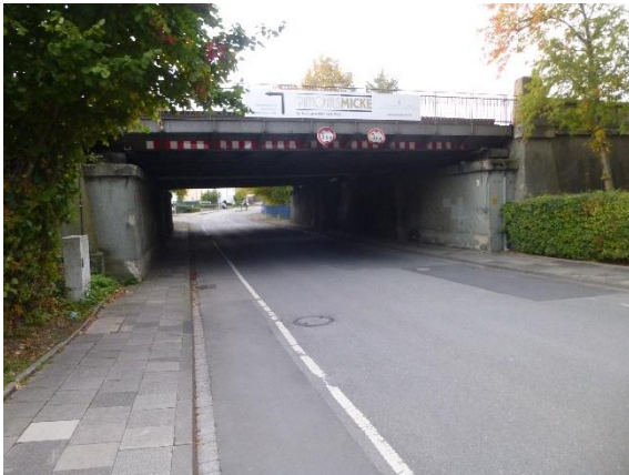
Abb. 22: Unterführung Ennigerloher Straße
