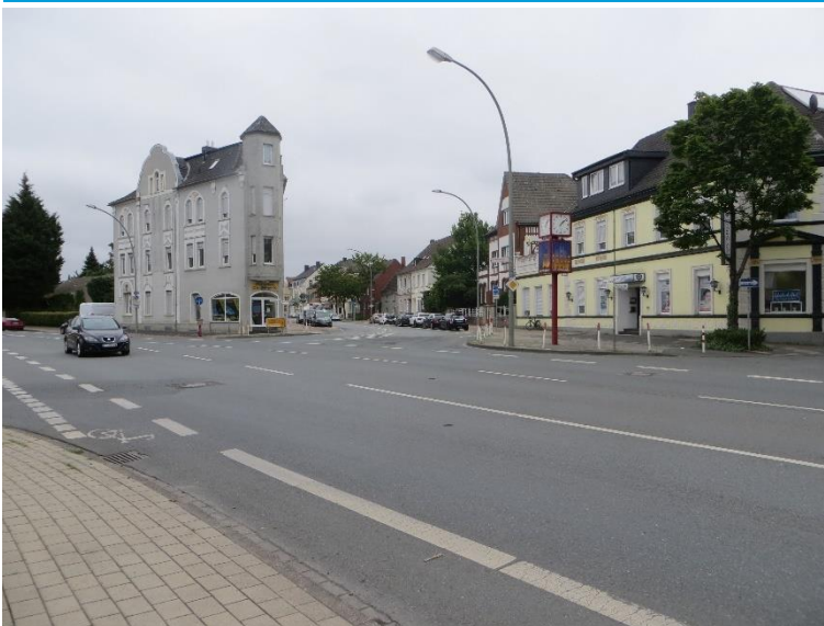
Abb. 14: Überwege zum Busbahnhof fehlen
