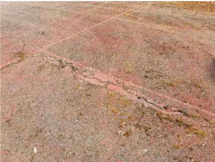
Bild 3: Beispiel eines Risses
