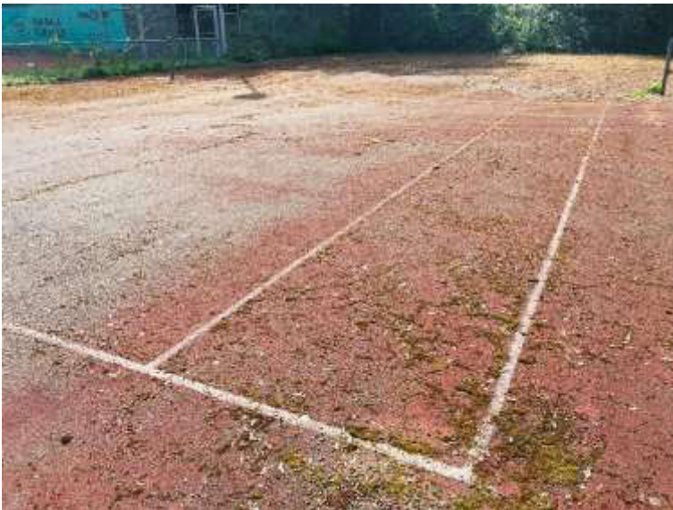
Bild 1: Blick auf den bestehenden Tennis-Hartplatz
