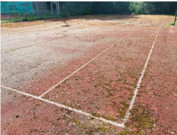
Bild 1: Blick auf den bestehenden Tennis-Hartplatz
