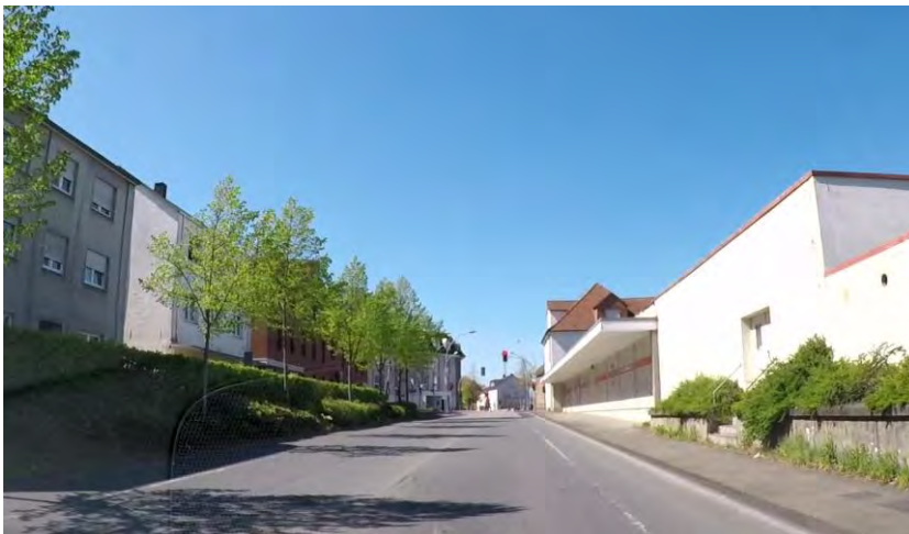
Abbildung 15 - Fehlende Radverkehrsinfrastruktur in der Bahnhofstraße in Neubeckum
