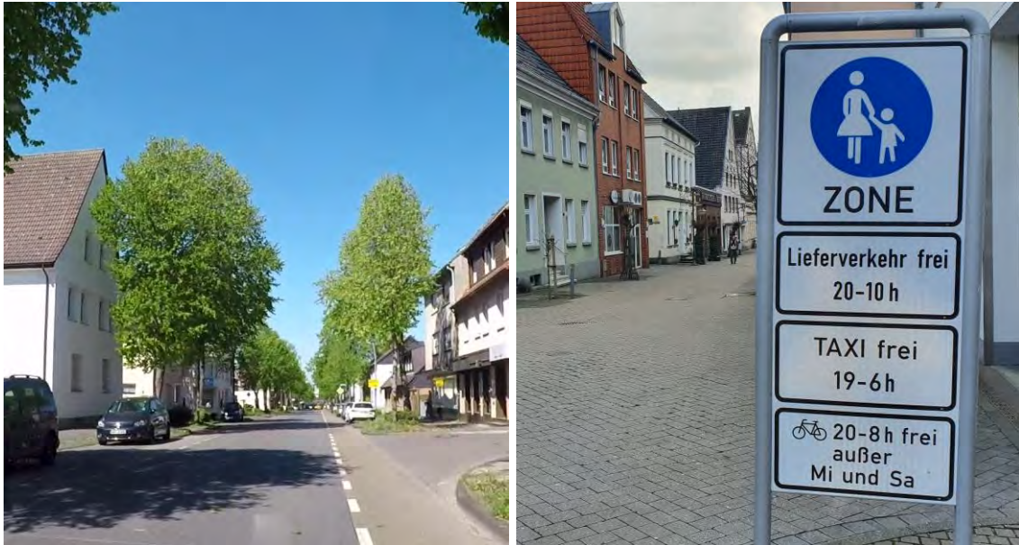
Abbildung 10 - Schutzstreifen auf der Hauptstraße, Neubeckum und Freigabe der Fußgängerzone in Beckum
