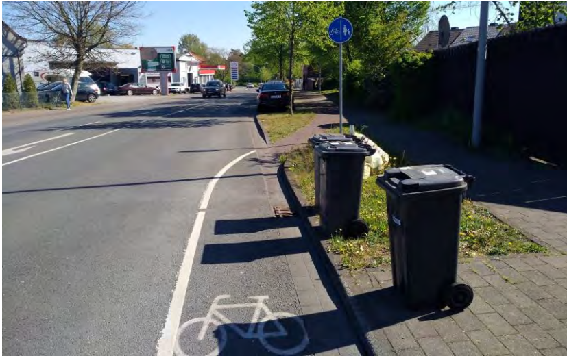
Abbildung 8: Wechsel von Fahrbahnniveau in den Seitenraum, Hammer Straße (Beckum)
