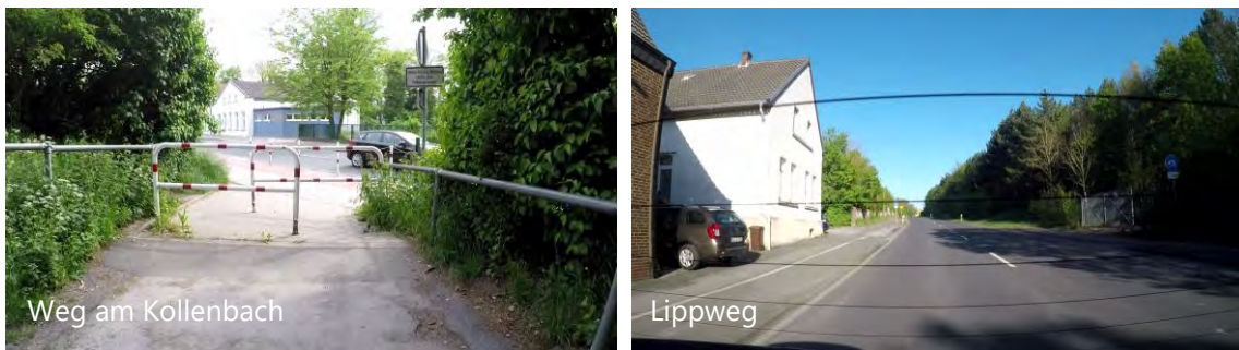
Abbildung 18 – Durchfahrtsperre (Weg am Kollenbach, links) und fehlende Querungsanlage (Lippweg, rechts) als Punktuelle Mängel
