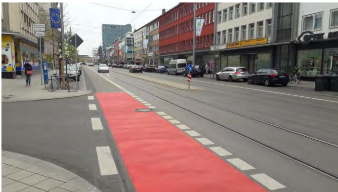
Abbildung 30: Good-Practice Beispiel: Friedrich-Ebert-Straße Kassel
