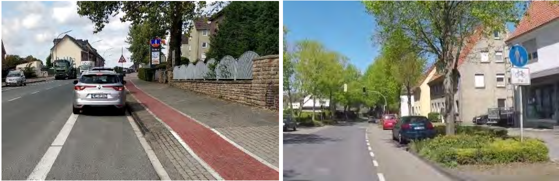
Abbildung 17 - Zu schmale Radinfrastruktur in der Vorhelmer Straße (links) und der Hauptstraße in Neubeckum (rechts)
