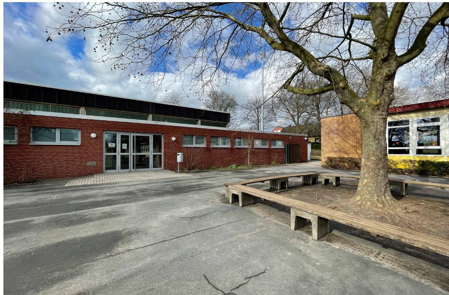
Foto Bestand Sonnenschule und Sporthalle
