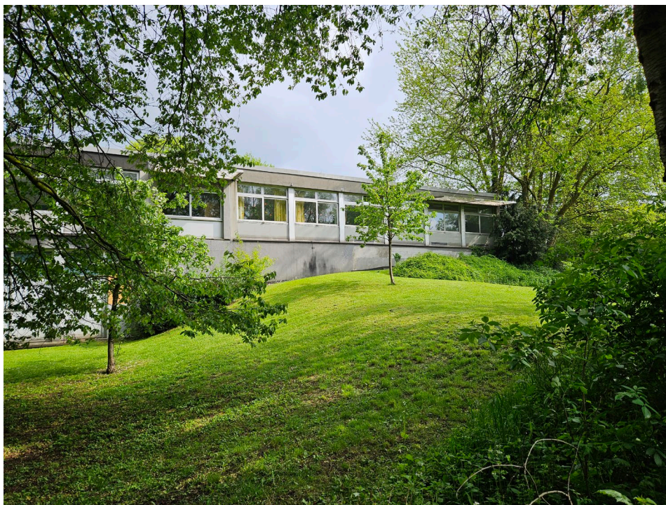
Abb. 2: Blick von Norden auf die Schule mit rückseitig der Gebäude gelegenem Baumbestand (Mai 2023).
