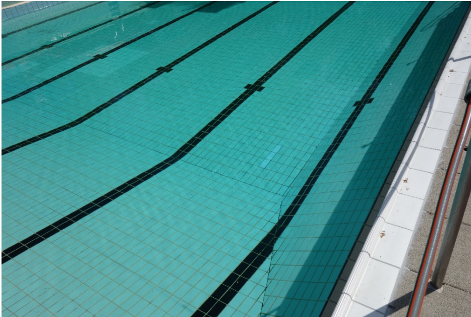
Schräge im Beckenboden zur Sprunggrube
