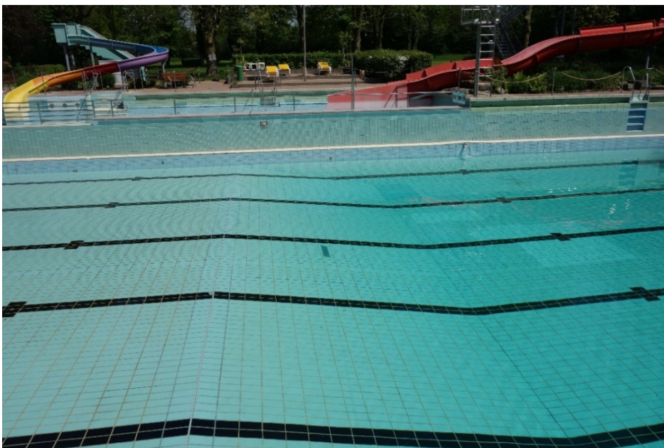
Schräge im Beckenboden zur Sprunggrube
