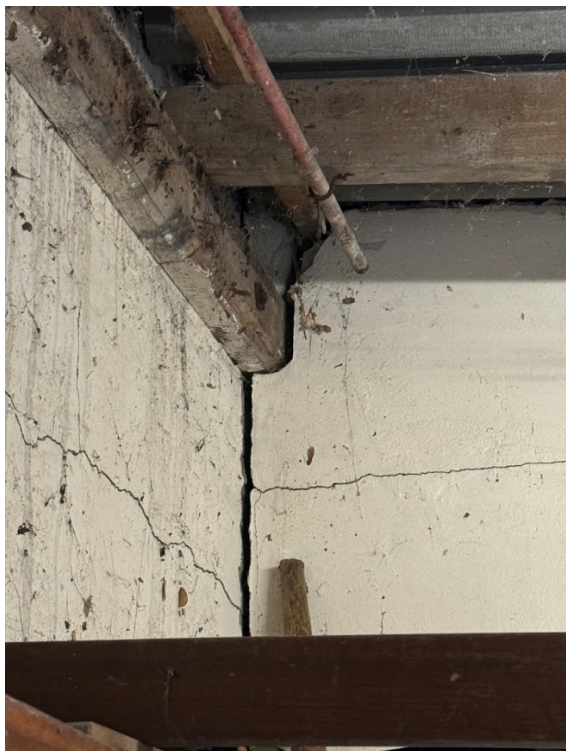
Versatz von Innen- und Außenwänden
