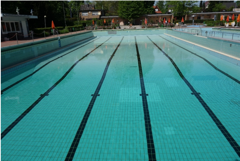
Blick auf das 50m Becken, vom Bereich Startsockel aus betrachtet
