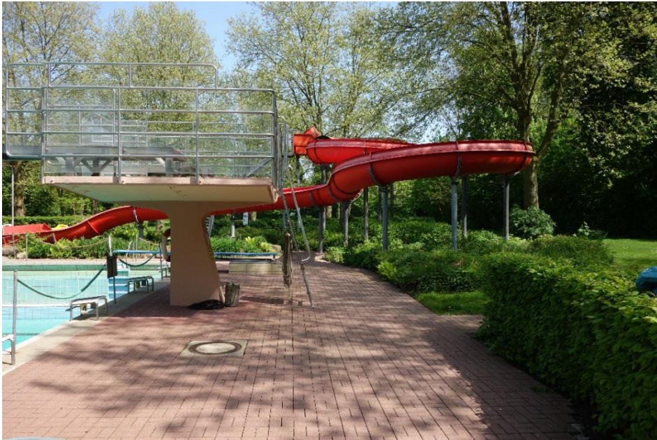
Sprunganlage stirnseitig auf Badeplatte
