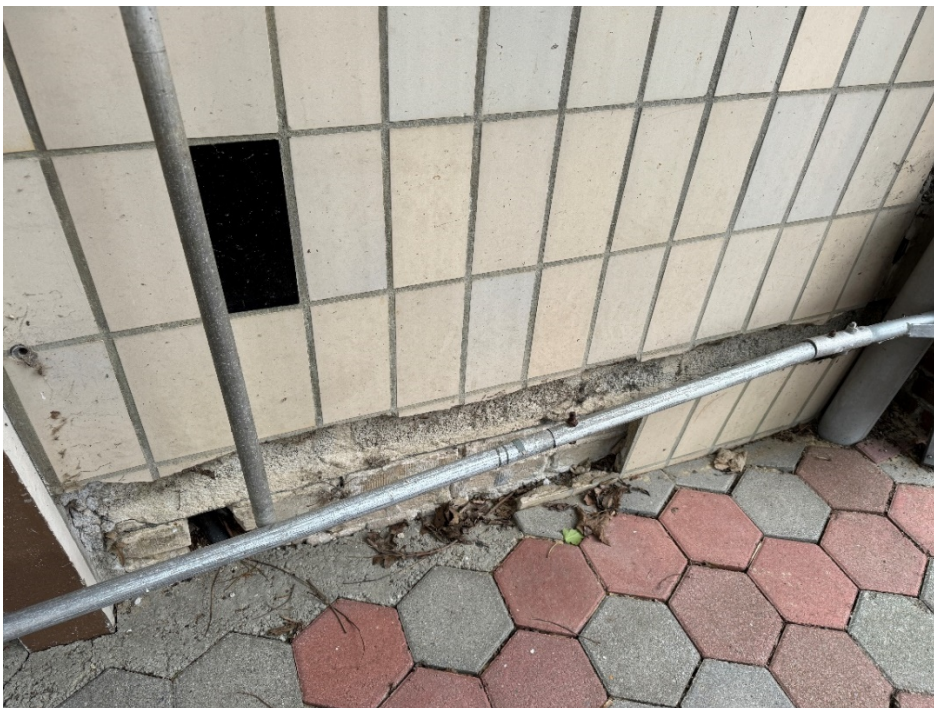
Provisorische Leitungsverlegungen
