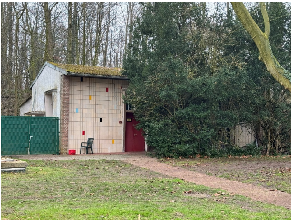
Bereich Zuwegung Technikgebäude
