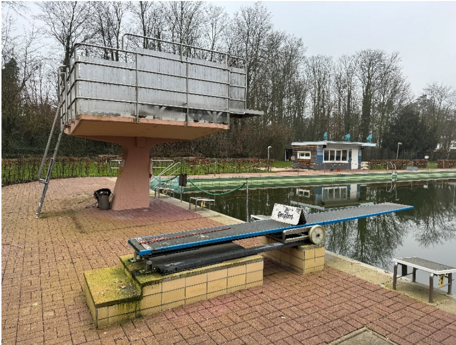
Startblöcke und Sprunganlage Stirnseite
