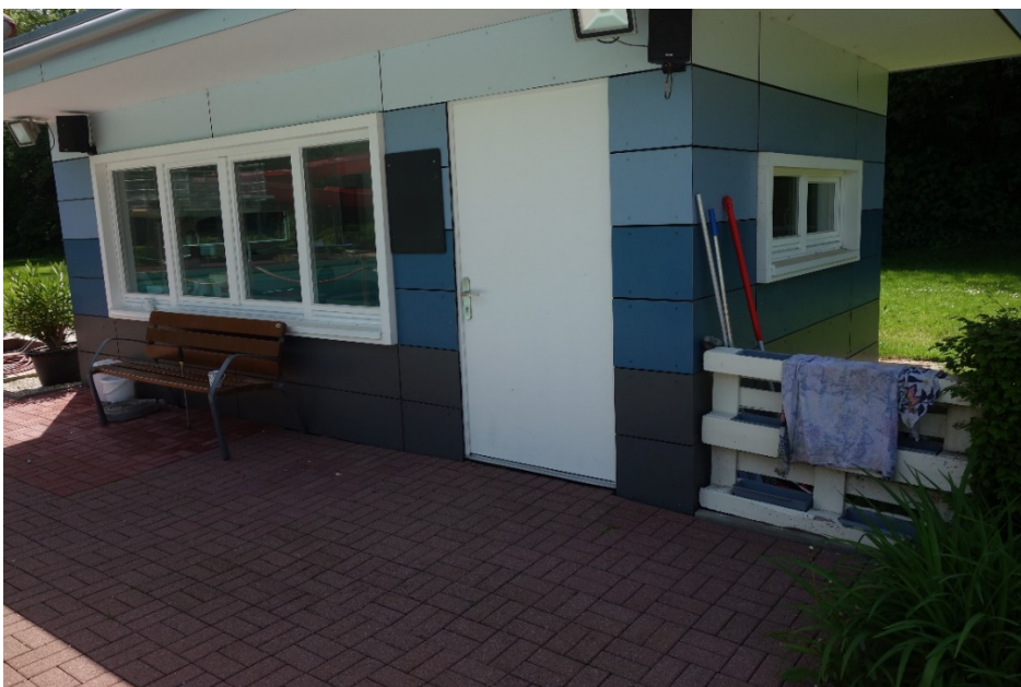
Dem Sportbecken seitlich vorgelagert befindet sich das Solitärgebäude der Schwimmaufsicht.
