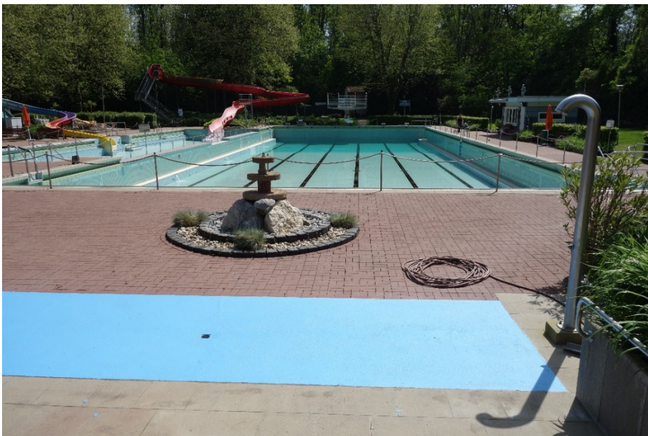
Blick über 50-m-Becken auf Rutschen und Sprunganlage
