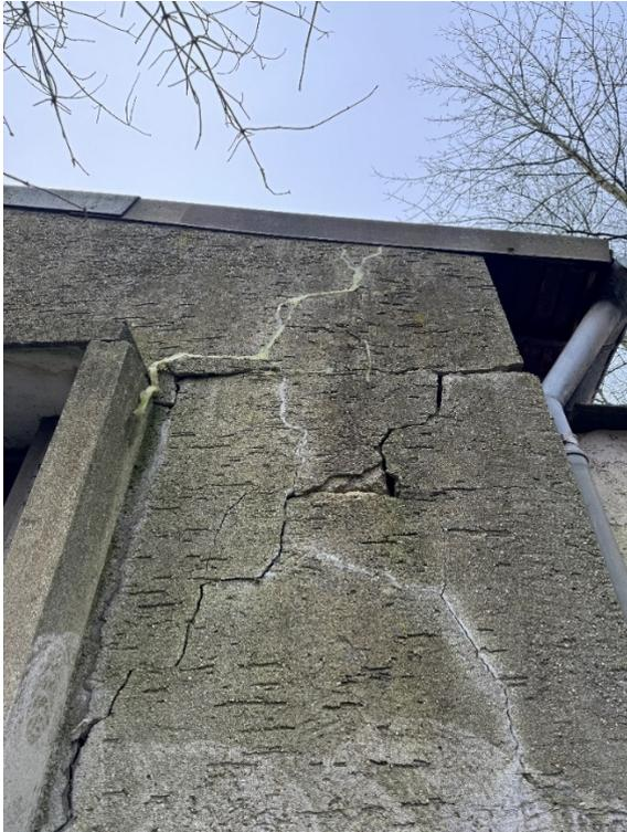
Massive Schädigungen der tragenden Außenwände
