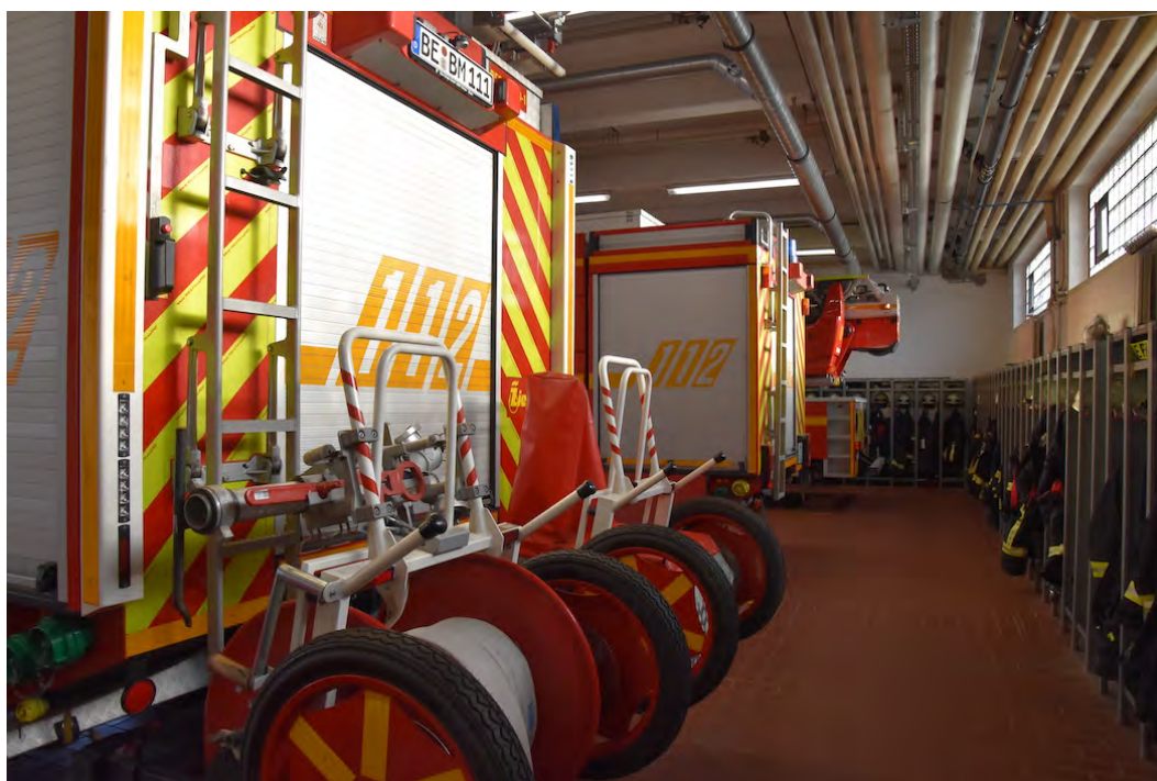
Abb. 7.3-9: FRW Beckum: neue Fahrzeughalle mit PSA in Spinden 1)
