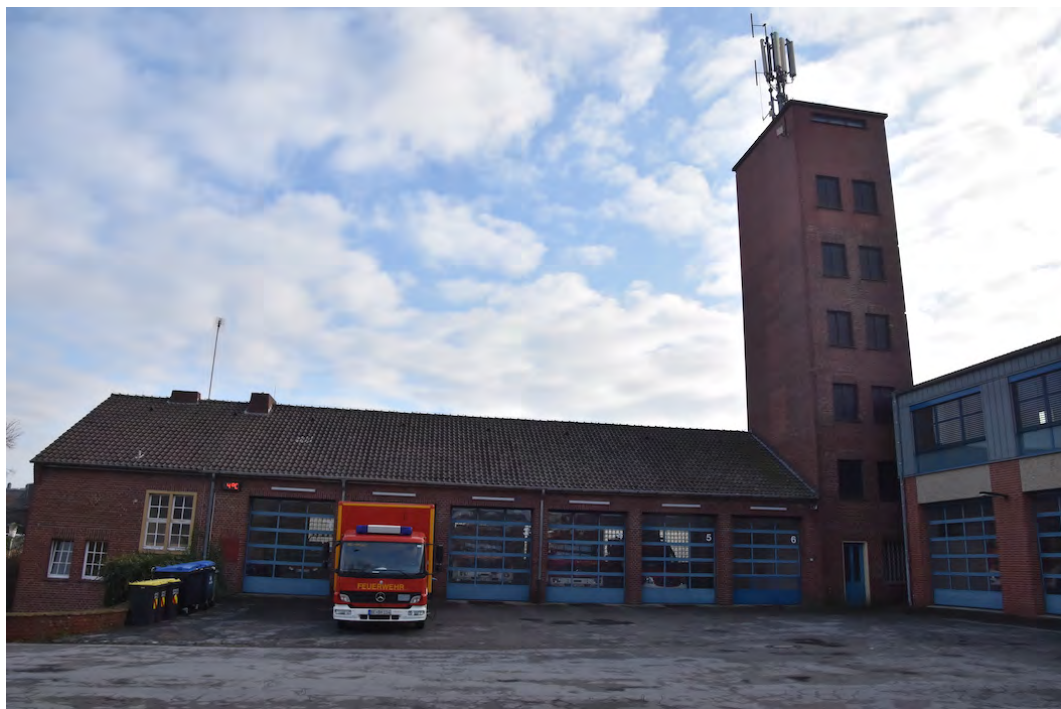
Abb. 7.3-2: FRW Beckum: alte Fahrzeughalle mit Schlauchturm
