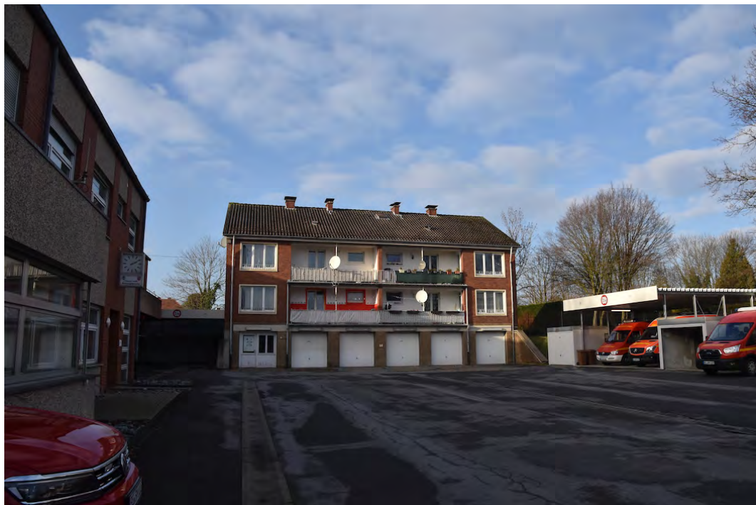
Abb. 7.3-3: FRW Beckum: Rettungswagenhalle mit Mietshaus
