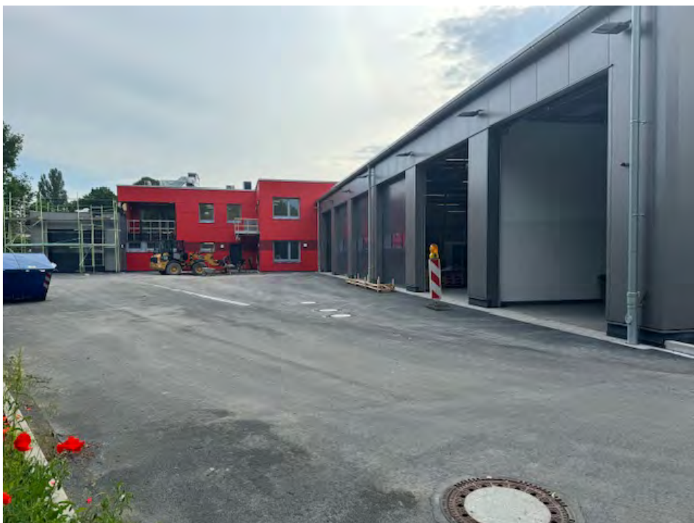
Abb. 7.3-12: FGH Neubeckum: Fahrzeughalle (4 Stellplätze + Waschhalle) (Foto: Scheele)
