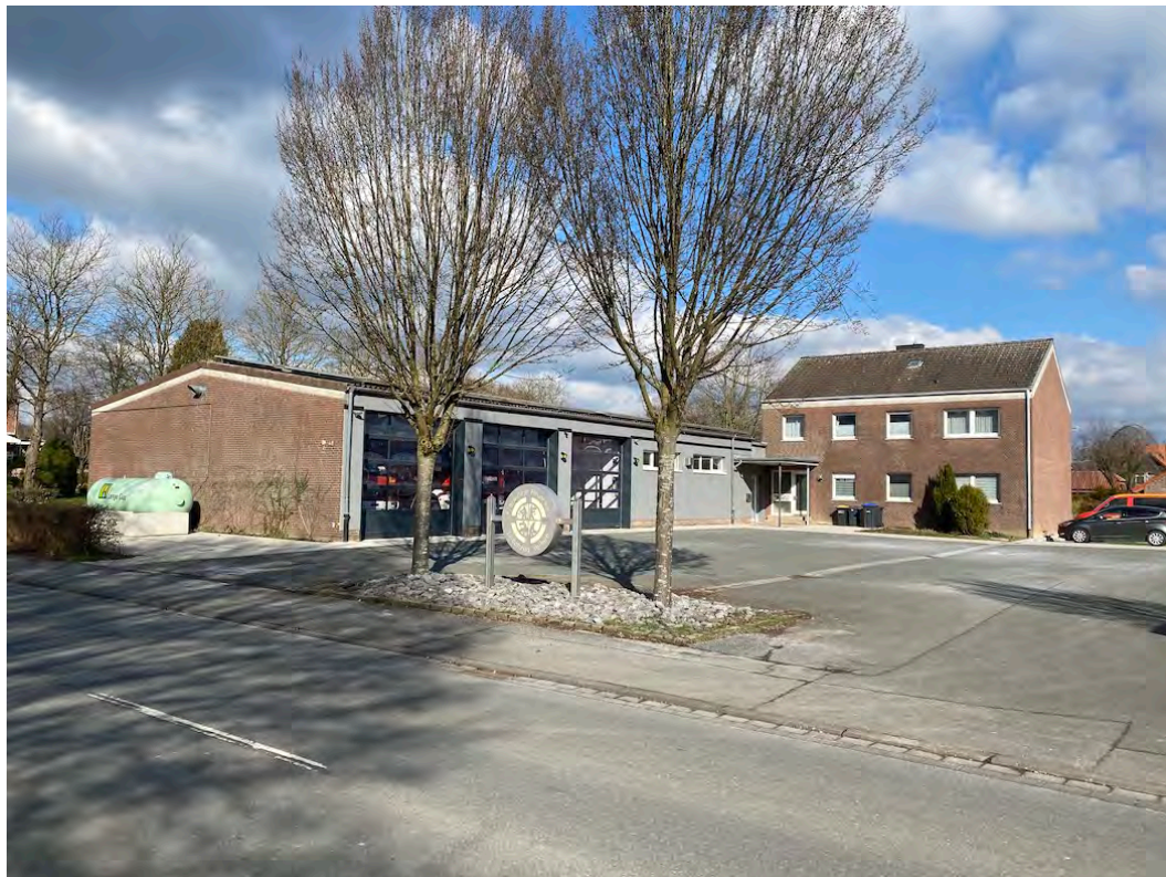
Abb. 7.3-15 FGH Vellern: Feuerwehrgerätehaus
