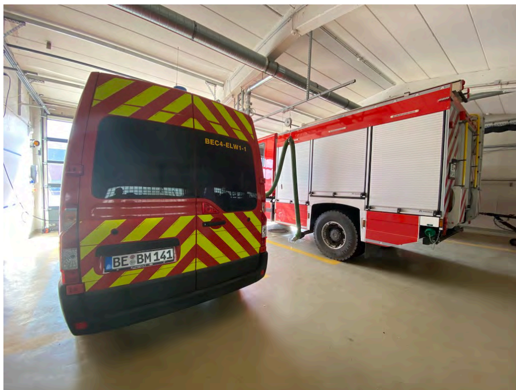
Abb. 7.3-16: FGH Vellern: Fahrzeughalle
