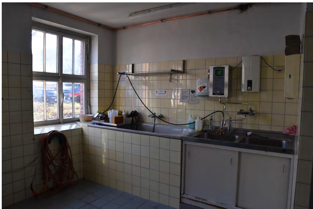
Abb. 7.5-2: Fw Beckum: Reinigungs- und Desinfektionsbecken in der Atemschutzwerkstatt
