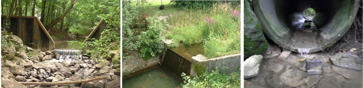
*Abb. 2: Bereits im Unterlauf des Hellbachs finden sich viele Querbauwerke (links: qbw\_2203 bei Station 1.3; mittig: qbw\_2204, St. 2.7). Auch im Hellbach-Oberlauf (stromauf der Mdg. des Geißlerbachs) behindern Absturzbauwerke die stromaufgerichtete Fischwanderung (rechts: qbw\_18525 bei St. 10.45; alle Foto: elwasweb).*
