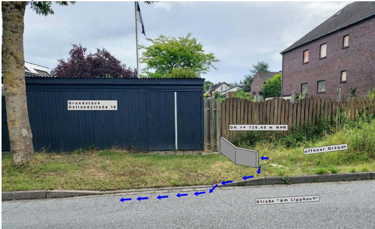
Abb. 5: Wirkung einer Mauer als Abflusshindernis
