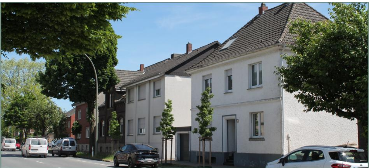
Abb. 5-9: Wohnbebauung an der Oelder Straße
