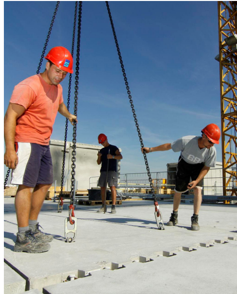
Decken und Dach
